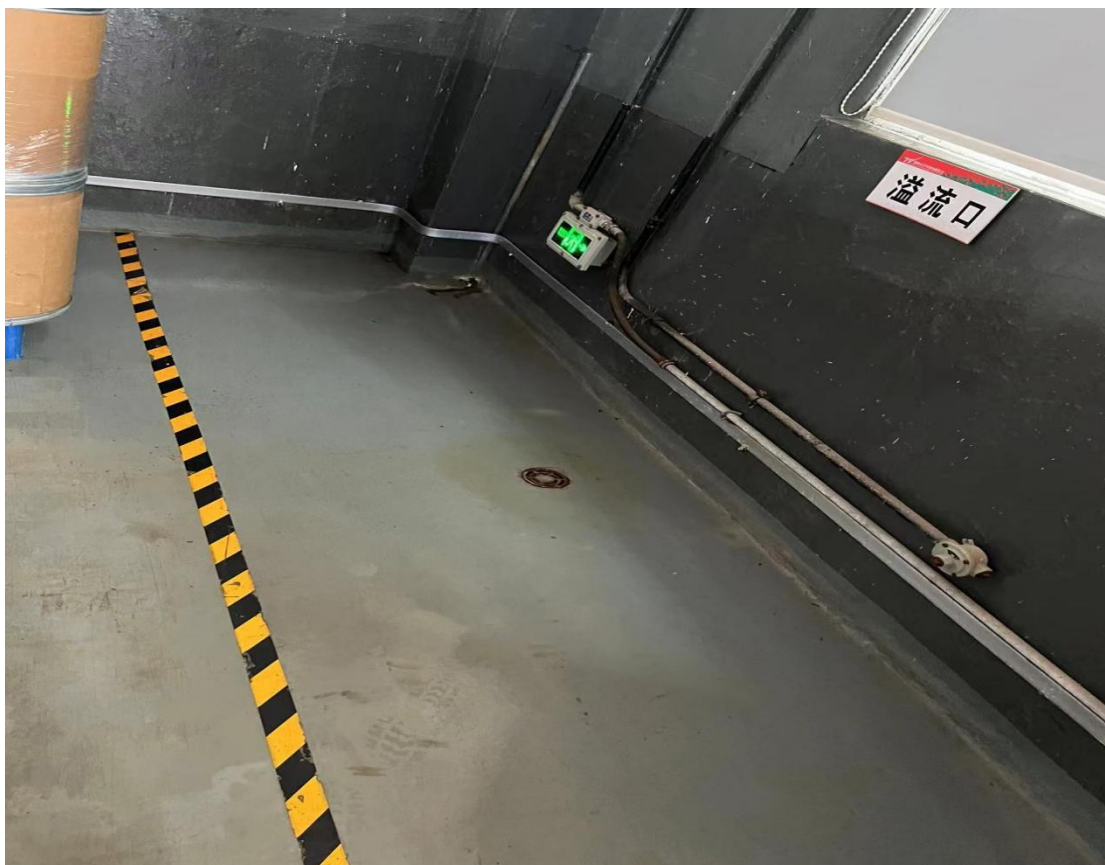
危废堆场内部照片
