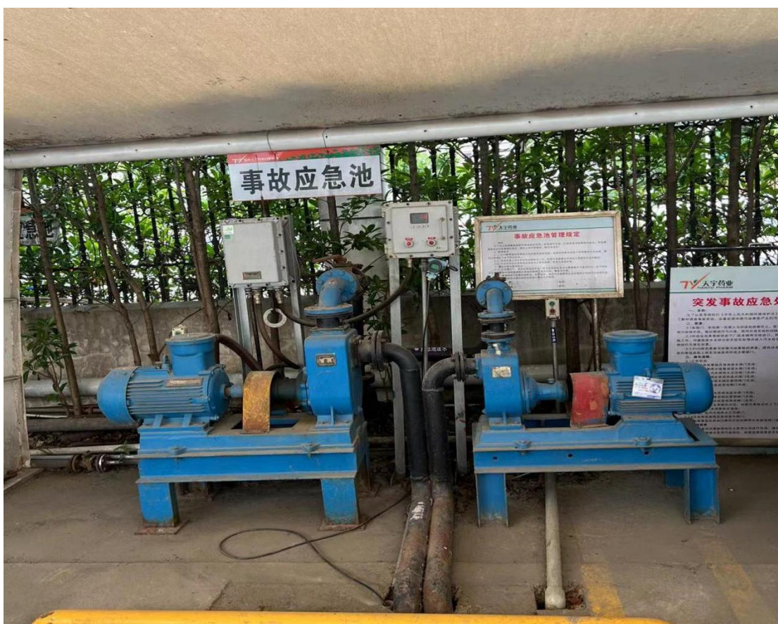
初期雨水收集池、事故应急池
