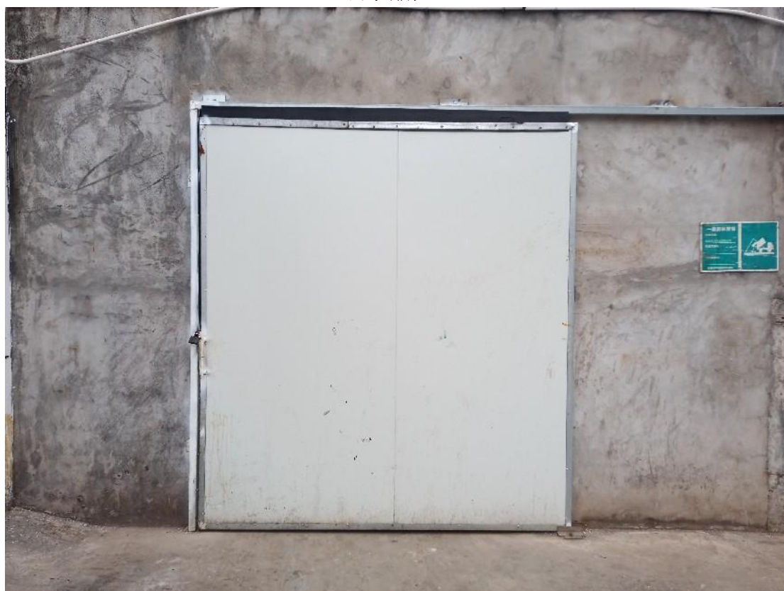
一般固废堆场
