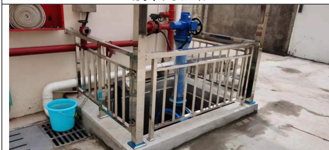
北厂区雨水排放口
