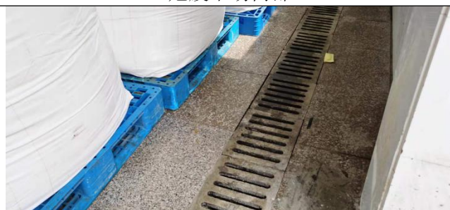
危废堆场导流沟
